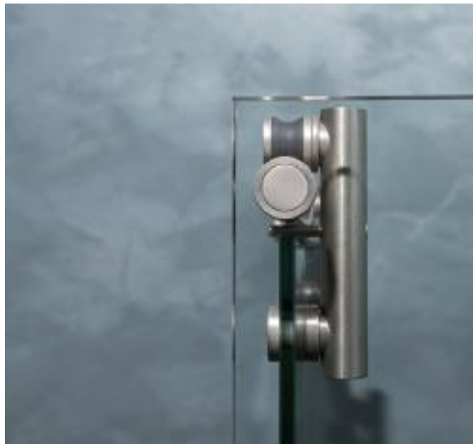
Schiene und obere Türkante – Ansicht durch das fixe Seitenteil. Wenige Teile für höchste Transparenz und deutlich einfachere Pflege.
