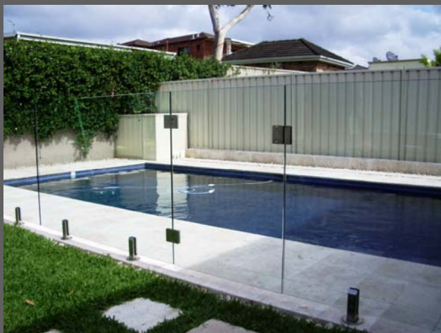
Montage pincé dans des plots scellés dans le sol
